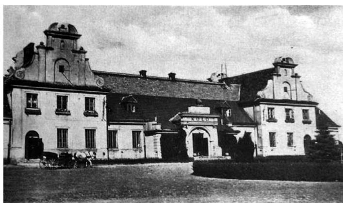
Budynek dworca kolejowego w Kole. Dworzec został wzniesiony w latach 1925–1928.
