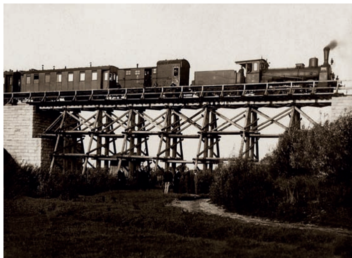
Próby obciążeniowe wiaduktu kolejowego pod Kutnem na budowanej w początku lat 20. XX w. trasie Strzałkowo – Kutno.
